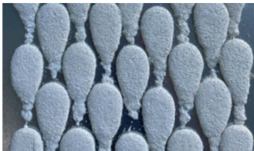
Obr. 10 Detail VDZ z termoplastického materiálu v provedení profilovaném
