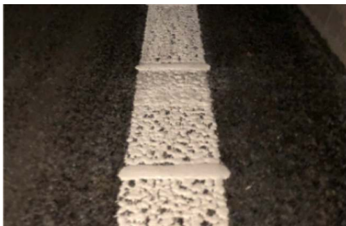
Obr. 9 VDZ z plastické hmoty nanášené za studena v provedení strukturálním s barety
