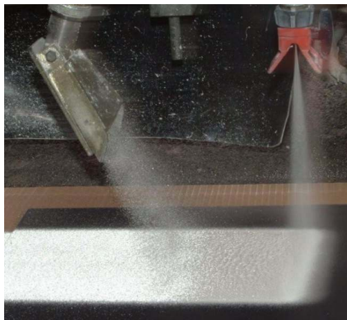
Obr. 1 Detail aplikace VDZ z barvy a materiálu na dodatečný posyp
