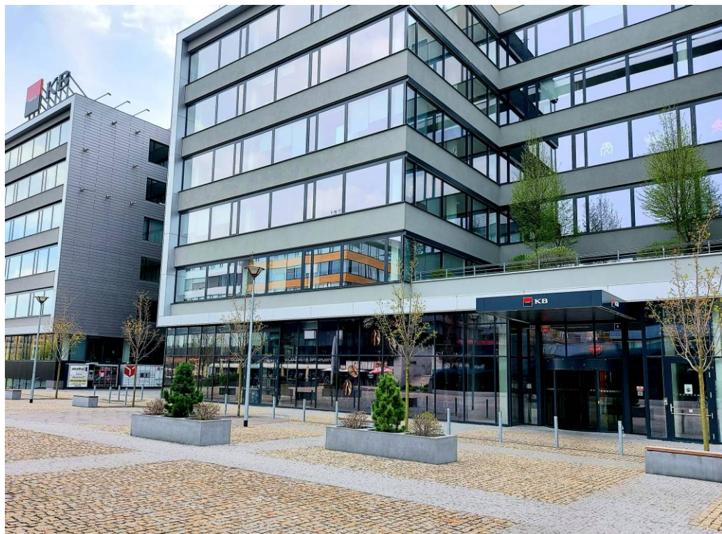
Prvky pasivní ochrany (betonové bloky) průčelí administrativního komplexu proti útoku motorového vozidla (2022, z archivu autorky)
