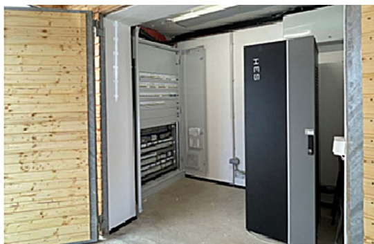
Bateriový systém v rámci pilotní instalace chytrého domu v Omicích u Brna, kde je užito prediktivní řízení a denní obchodování s energií.
